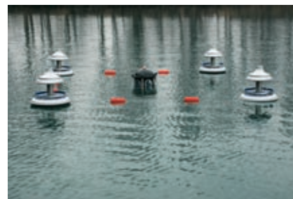
In de 4 eilandjes, of wachtplaatsen voor kijklustigen, zit een winch verborgen. Het samenstel van winches zorgt ervoor dat de centrale duikklok kan dalen en stijgen.
